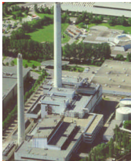
Heizkraftwerk im Werk Sindelfingen
