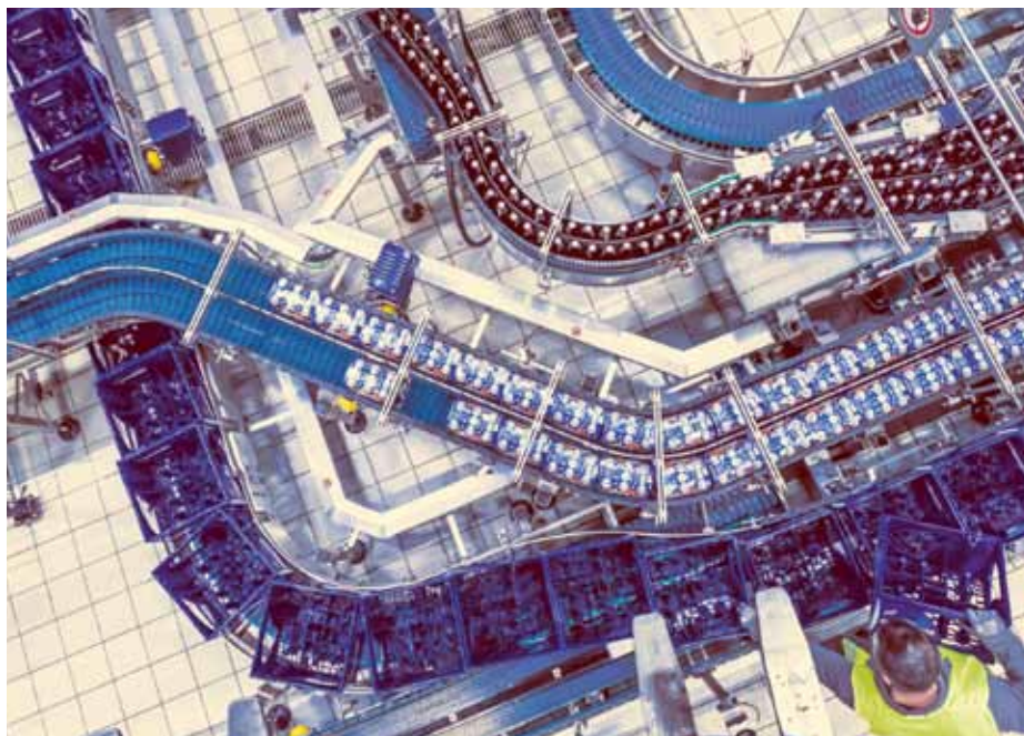
TeBIS unterstützt die Überwachung der Multipackanlage
